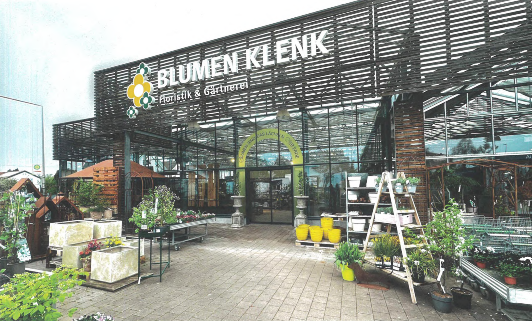
Vor dem Umbau befanden sich Ein- und Ausgang der Gärtnerei im Warmhaus. Nun ist beides getrennt voneinander, was die Kundenführung erleichtert.
